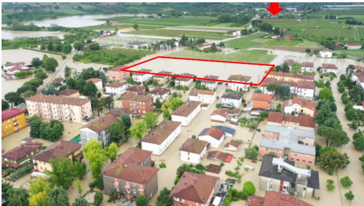
FOTO RIPRESA IN DATA 17/05/2023 ALLE ORE 6:30 DEL MATTINO – LA FRECCIA ROSSA INDICA LA POSIZIONE DELLA PRINCIPALE ROTTURA DELL'ARGINE DEL FIUME SENIO – IL CONTORNO ROSSO INDICA L'AREA DI PROGETTO
